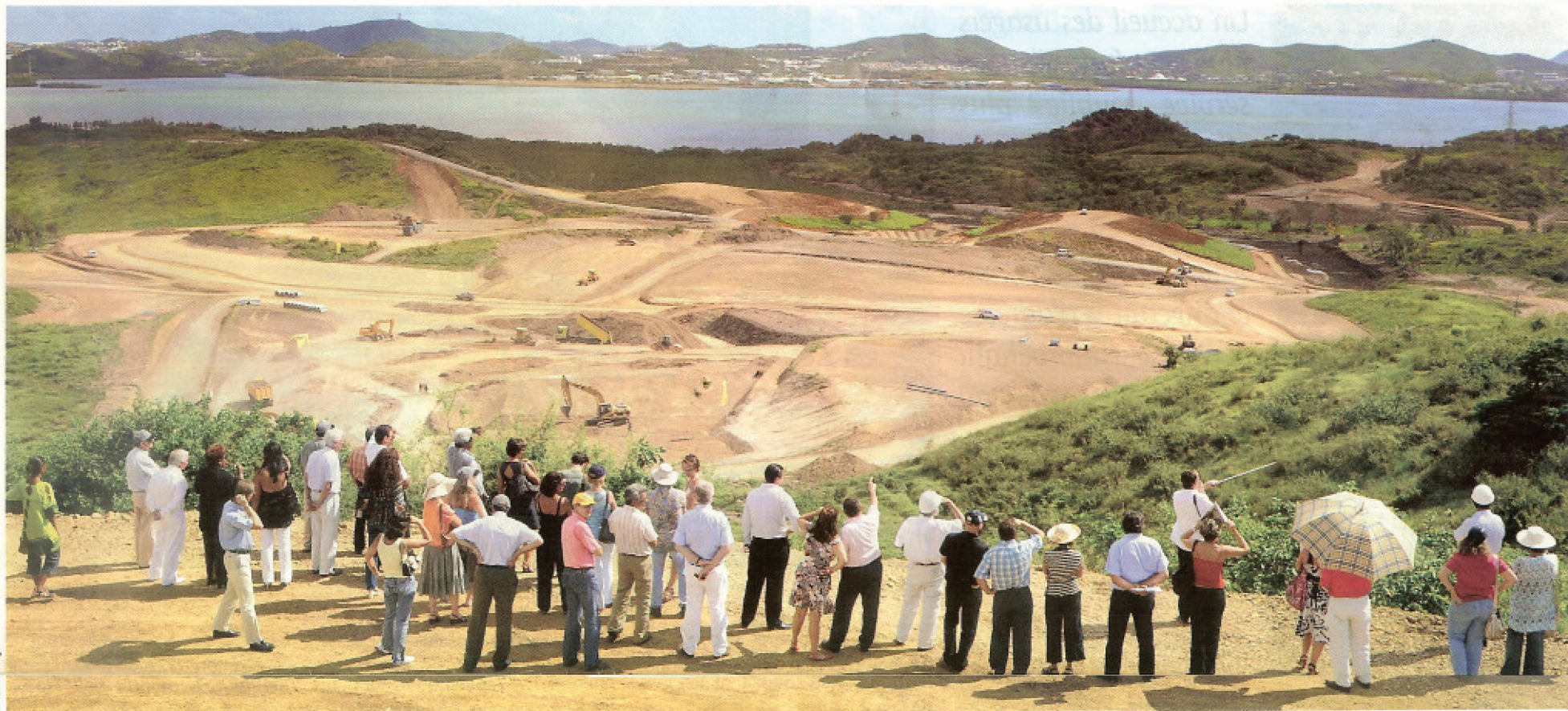
Le 12 décembre, tous les acteurs du projet étaient invités à mesurer sur place l'ampleur du chantier.
