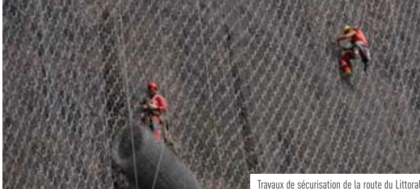
Travaux de sécurisation de la route du Littoral.
